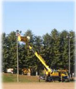
老朽化したグラウンド照明灯の支柱取替え作業 リンク造成・維持に威力を発揮します。 19日(金)
